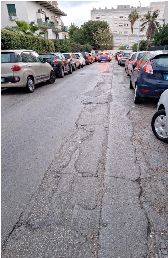
100ammaloramento per traffico intenso e rappezzi
