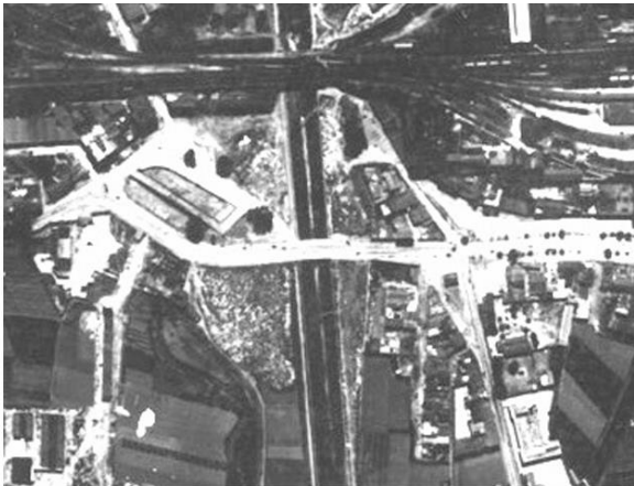
fig 8 Trasformazione urbana della Piazza con l'avvento della rettificazione dell'alveo e realizzazione del nuovo ponte in cemento armato realizzata nel 1932 - ritrovamento del ponte delle Teste Mozze avvenuto con la demolizione del ponte degli anni '30 e la costruzione di quello bimodale. Informazioni ed immagini tratte da: IL PONTE DELLE TESTE SUL FIUME ORETO Giovanni Fatta Dipartimento di Architettura (DARCH) Università di Palermo Viale delle Scienze, 90128 Palermo, Italy
