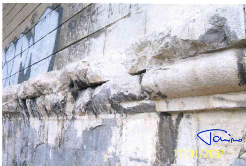
Figura 5. Cornici erose
