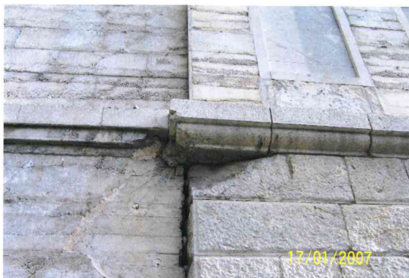
Figura 6. Erosione del Billiemi - malta distaccata dal supporto in c.a.
