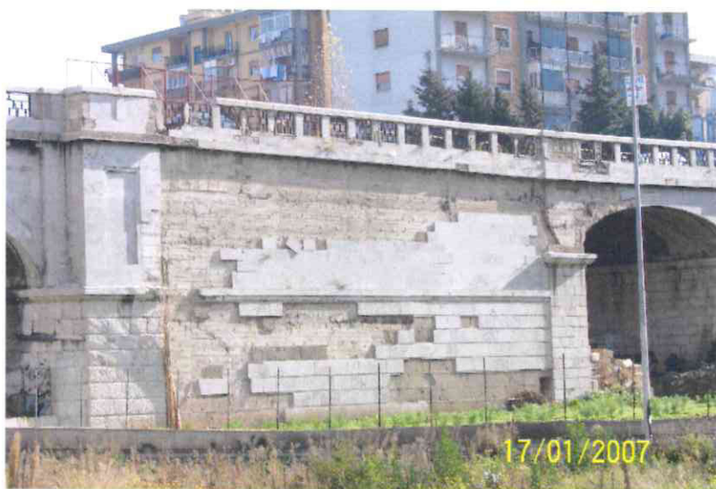
Figura 4. Perdita di materiale - lastre di Billiemi
