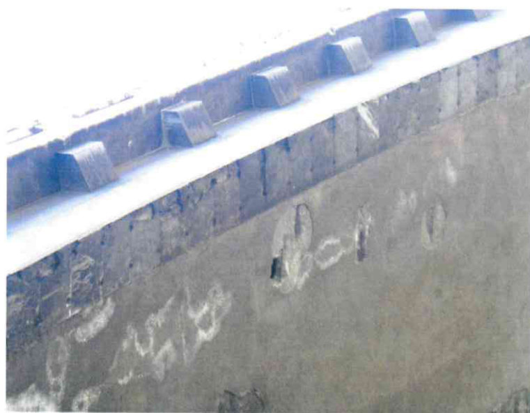
Figura 3. Croste nere ed efflorescenze saline
