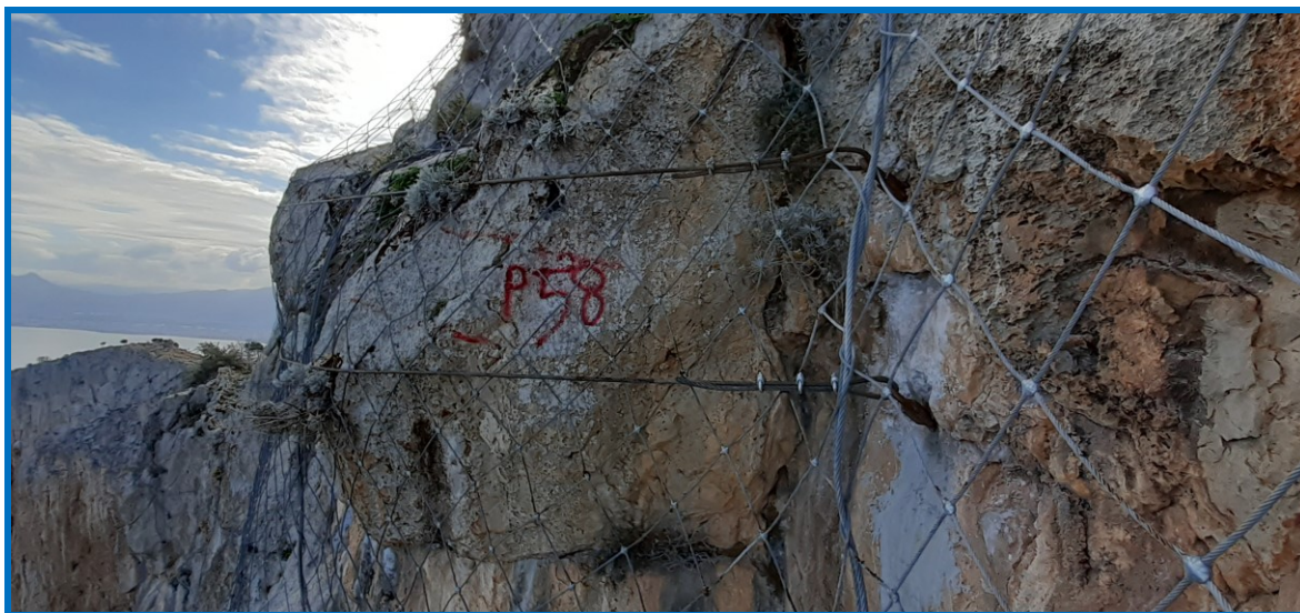
Fig. 6 - Intervento attivo di tipo puntuale di consolidamento del blocco lapideo P58
